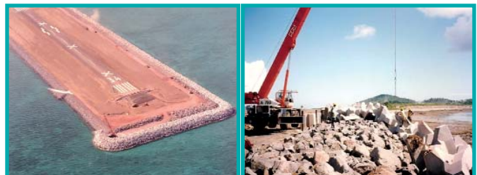
Construction de la piste 1995 (SOGREAH, 1995)
